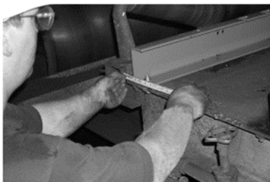
Рис. 2. Монтаж противоударных опор Martin®
