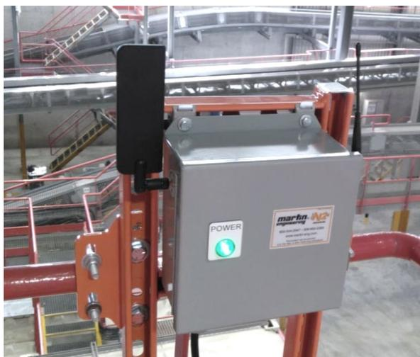
1. Déterminer l'emplacement de la passerelle. Celle-ci doit être montée dans un endroit élevé le plus proche du centre de tous les indicateurs de position.
