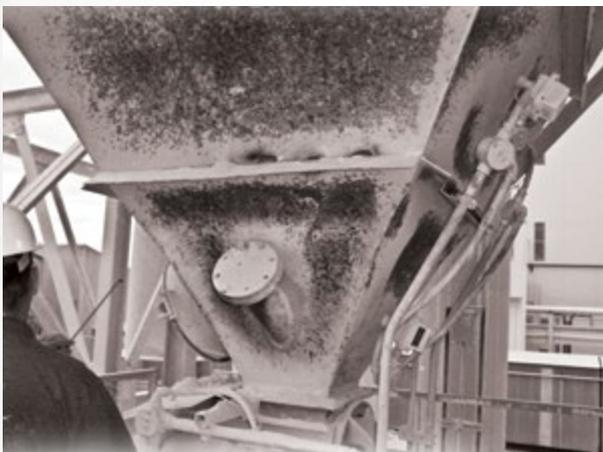
Le martèlement contre la paroi du cône ou de la goulotte entraîne des dommages à la surface de la paroi, souvent appelés « coups de masse ».
