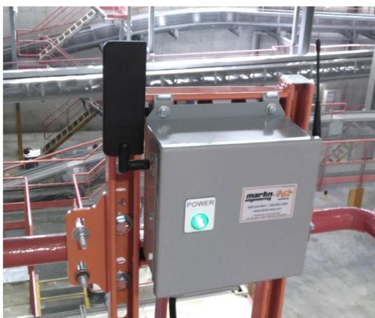
1. Bestimmen Sie den Standort für das Gateway. Das Gateway muss an einer erhöhten Stelle montiert werden, nahe dem Zentrum der Positionsindikatoren.
