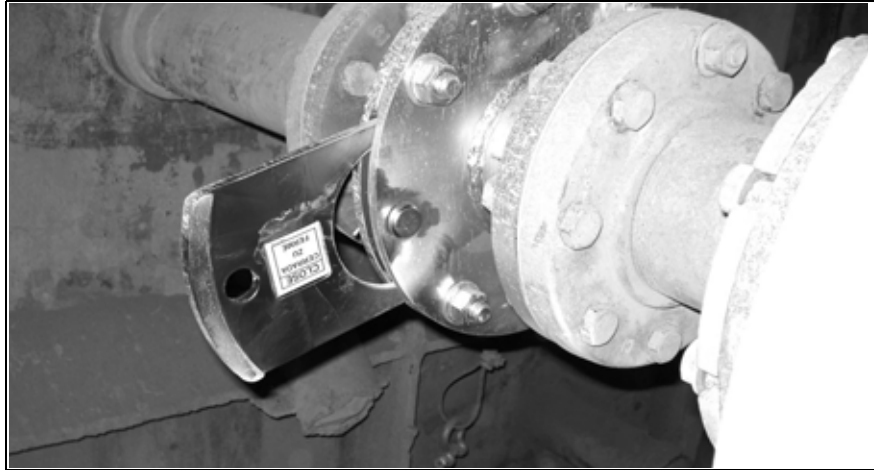
Abb. 23: Öffnen des Sicherheitsschiebers
