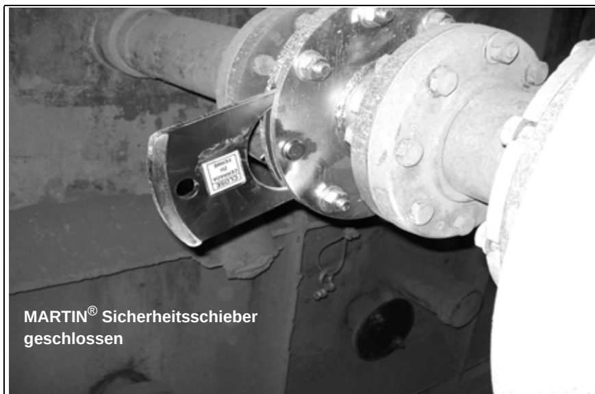
Abb. 13: Schließen des Sicherheitsschiebers
