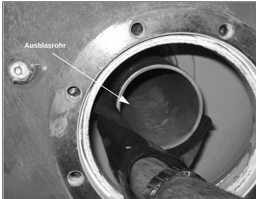
Abb. 19: Luftkanone überprüfen
