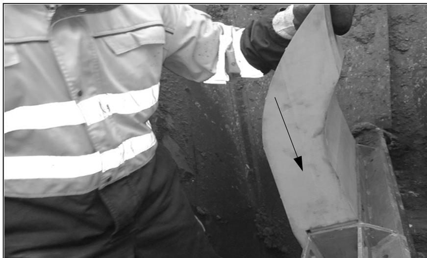
Abb. 11: Einsetzen des Abstreiferblattes
