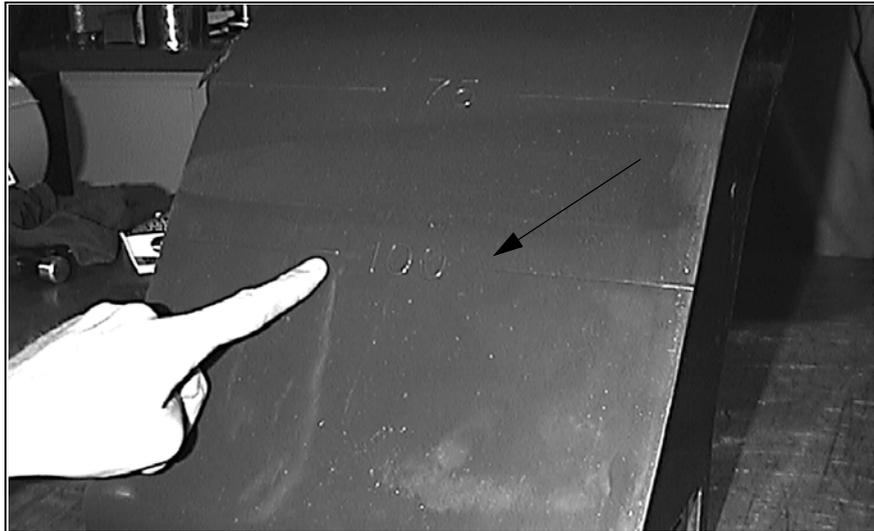
Abb. 19: Darstellung der 100 % Verschleißmarkierung
