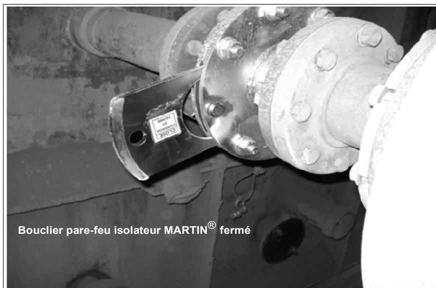
Fig. 13 : Fermeture du bouclier pare-feu isolateur
