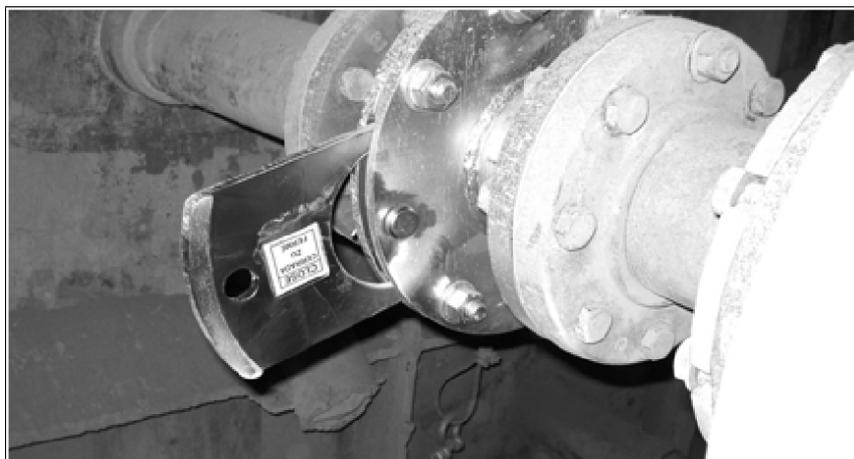
Fig. 23 : Ouverture du bouclier pare-feu isolateur
