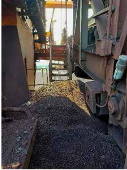
Şekil 8. Merdivenlerdeki ve yürüyüş yollarındaki birikme/yığılma işyeri tehlikelerine yol açıyordu Figure 8. Cluttered stairs and walkways created a workplace hazard
