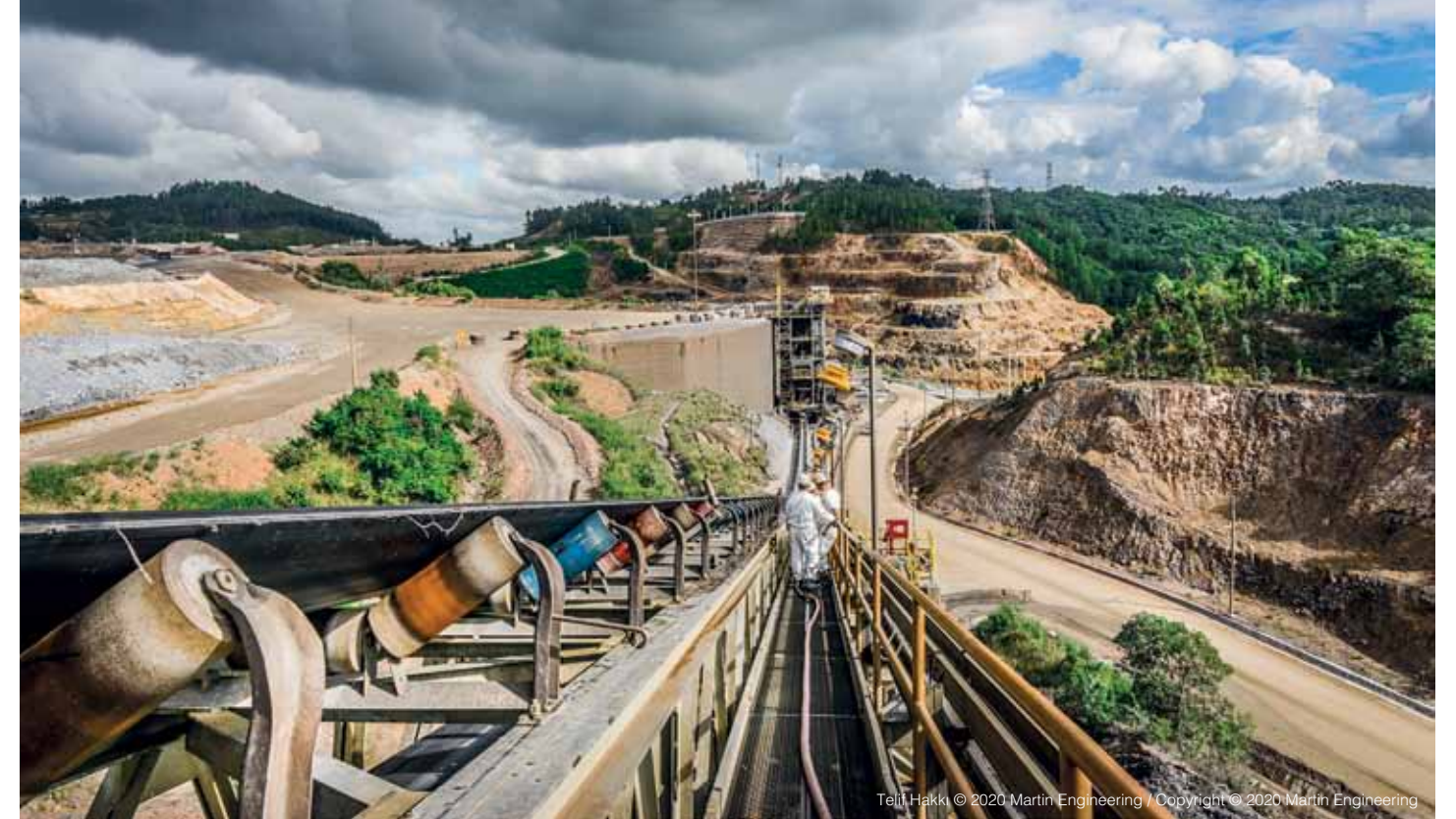
Konveyörler, temel proseslerin neredeyse tamamıyla etkileşime giren karmaşık sistemlerdir. Conveyors are complex systems that interact with almost all key processes.
