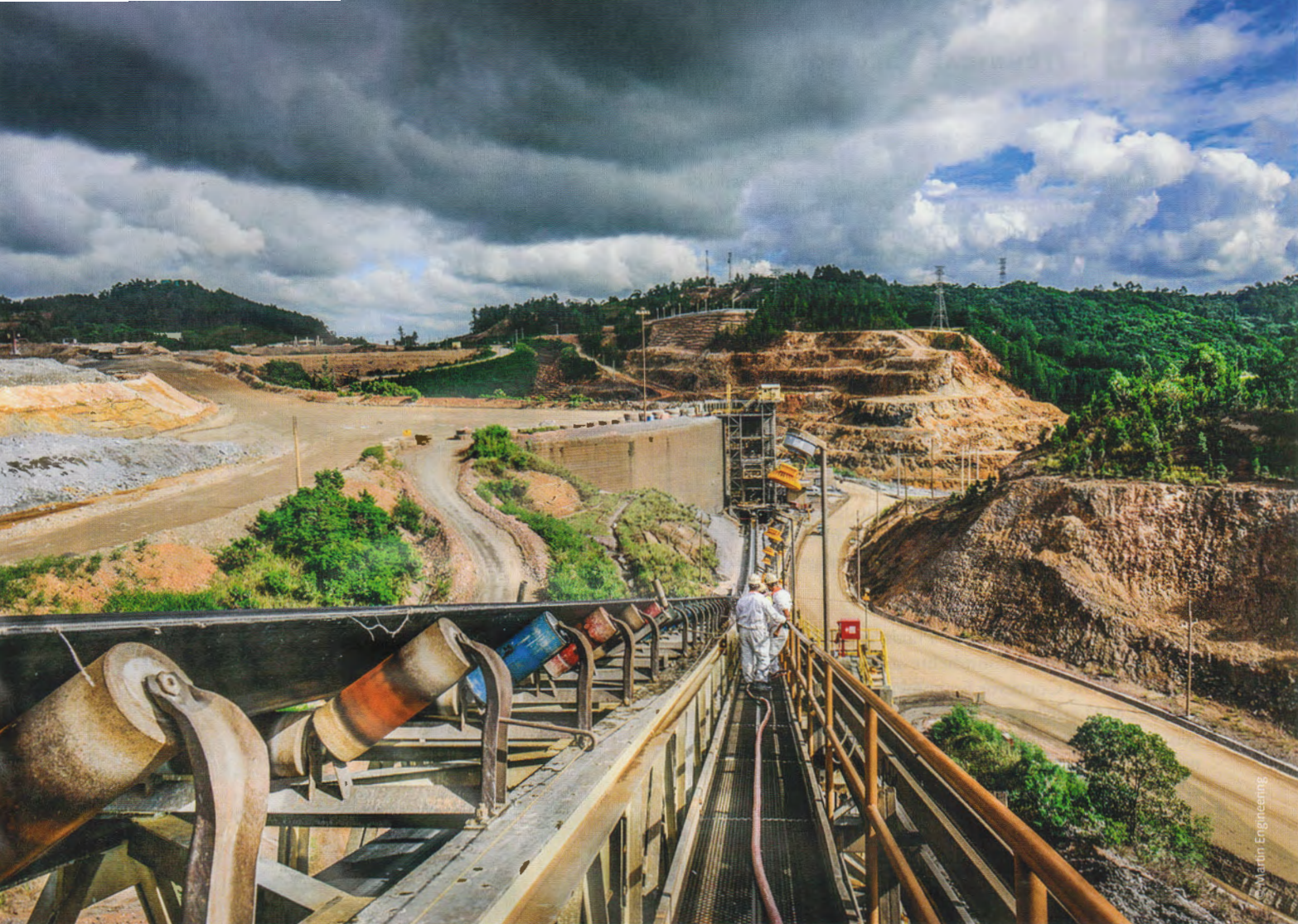
1 Förderer sind komplexe Systeme, die mit praktisch allen wichtigen Prozessen interagieren Conveyors are complex systems that interact with virtually all major processes
