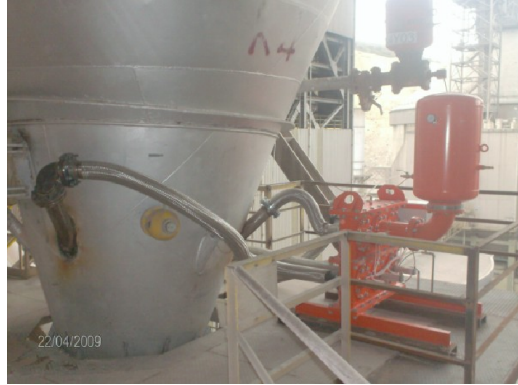
Siklon Konik Mal Akış Borusu Başlangıcı
