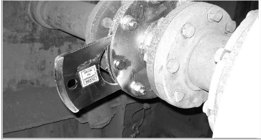
Şekil 23: Termik güvenlik kalkanının açılması
