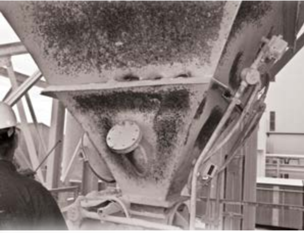
Silo ya da şut duvarına çekiçle vurmak yüzeyi hasara uğratabilir; buna "çekiç hasarı" denir.
