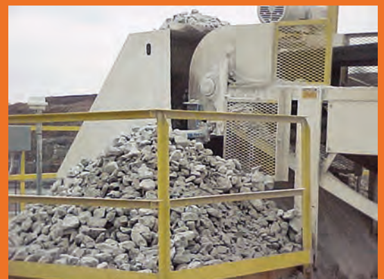
Um detector de chute obstruído resulta no acúmulo de materiais nas passagens e no aumento do risco de acidentes entre trabalhadores.
