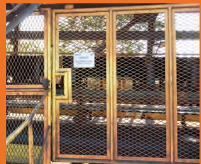
O portão para a passarela do transportador é controlado por um sensor de RFID.
