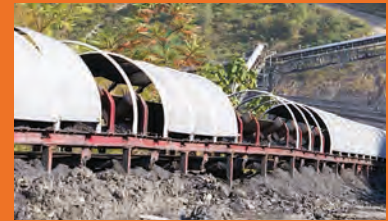
Coberturas não recolocadas após a manutenção podem expor os trabalhadores a perigos.
