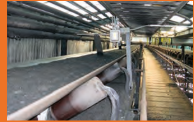
Galeria para transportador típica, vista do interior.
