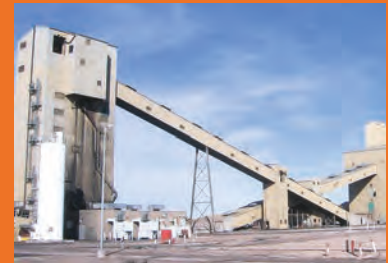
Galeria para transportador típica, vista do exterior.
