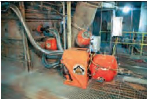
geralmente é instalado na parte de 1/4 a 1/3 inferior da estrutura. Se for necessário um segundo vibrador, ele deverá ser montado a 180° a partir do primeiro vibrador e na metade superior da estrutura.
