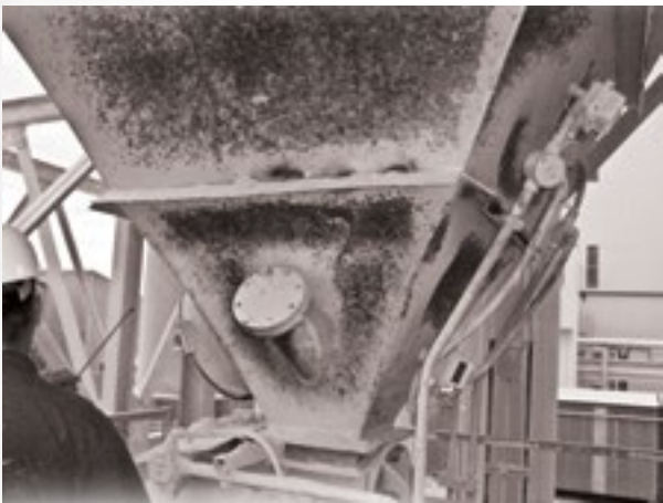
Das Einschlagen auf die Bunker- oder Schurrenwandung mit einem Hammer führt zu einer Beschädigung der Wandungsfläche.
